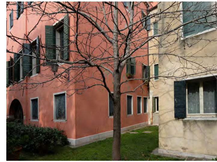
CONDOMINIO PROSPETTO INTERNO FINESTRE APPARTAMENTO PIANO PRIMO
