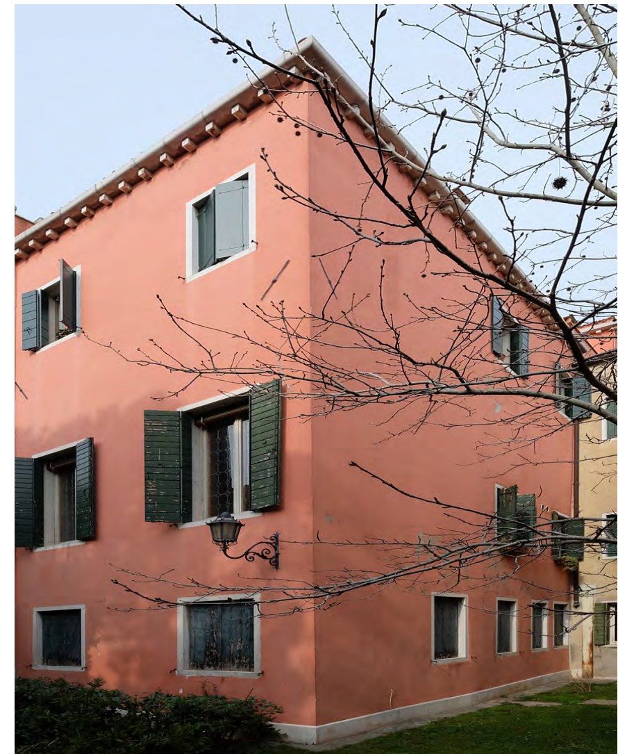
CONDOMINIO PROSPETTO INTERNO FINESTRE APPARTAMENTO PIANO PRIMO
