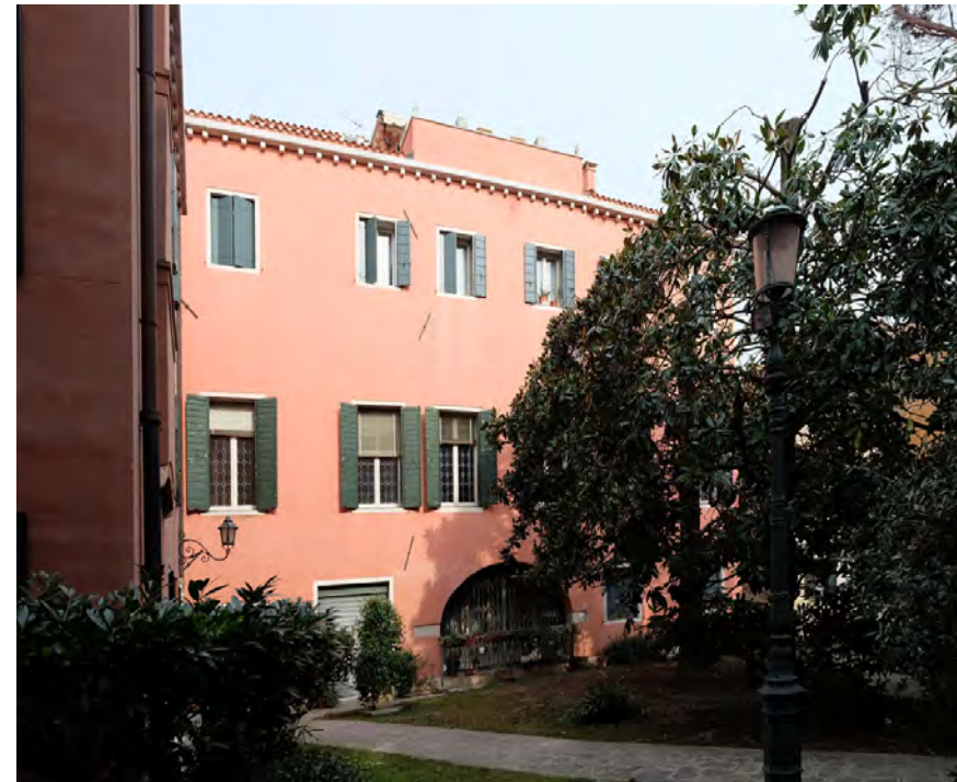
CONDOMINIO PROSPETTO INTERNO FINESTRE APPARTAMENTO PIANO PRIMO
