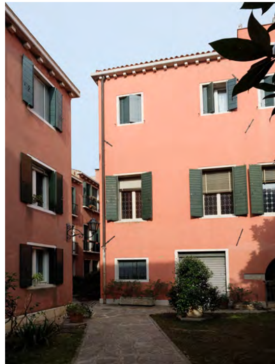
CONDOMINIO PROSPETTO INTERNO FINESTRE APPARTAMENTO PIANO PRIMO
