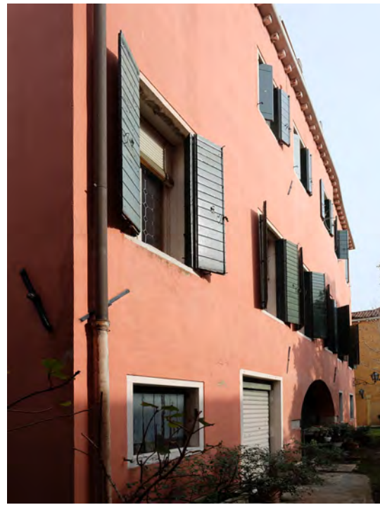
CONDOMINIO PROSPETTO INTERNO FINESTRE APPARTAMENTO PIANO PRIMO
